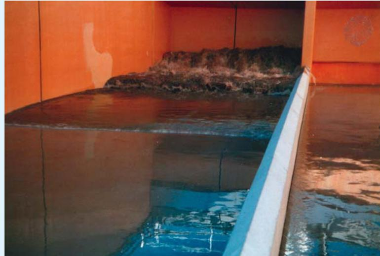
Bild 4 Schwallreinigung mit Vakuumtechnik im Rechteckbecken
