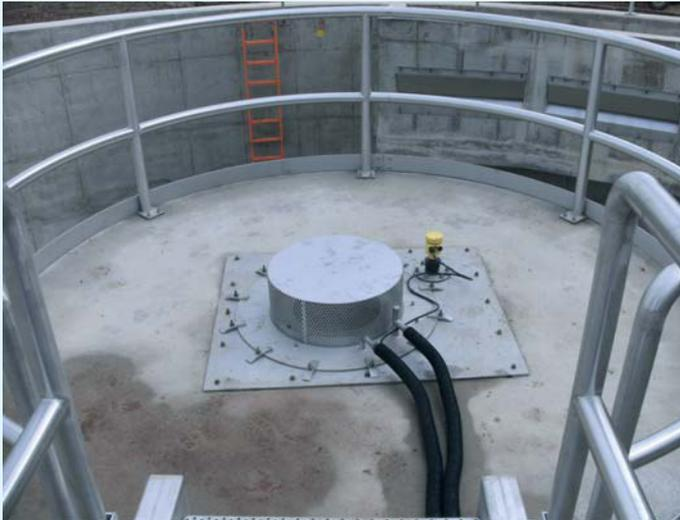
Bild 3 Rundbecken mit Auslöseventil auf der zentralen Spülkammer
