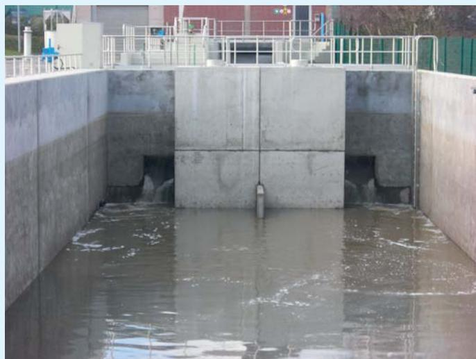
Bild 6 Spülkammer aus Betonfertigteilen zum nachträglichen Einbau in bestehende Becken
