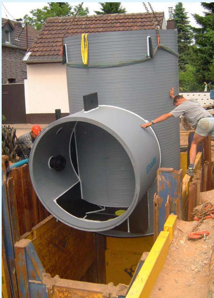
Bild 5 Spülung eines Stauraumkanals mit der Vakuumspülung, auch mit PE Spülkammer möglich
